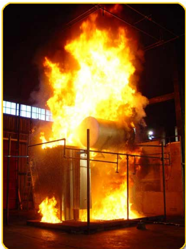
شکل ۱- خطر انفجار و آتش‌سوزی ترانسفورماتورهای روغنی
